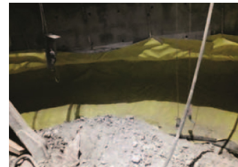
Fot. 6. Hydroizolacja w stopie szybowej
