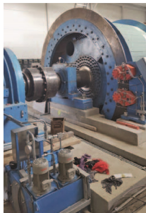
Fot. 3-4. Fundamenty i montaż
