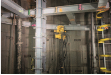
Fot. 7. Trasa urządzenia do rozwijania folii wraz z wciągnikiem PWS-3
