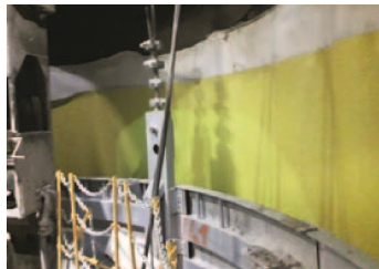
Fot. 5. Hydroizolacja zabudowana na obudowie panelowej
